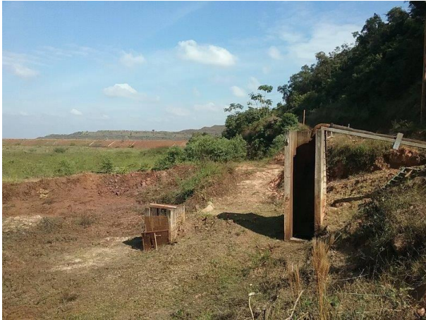
Redução capacidade extravasora concluída.
