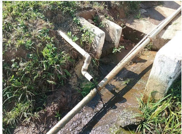
Dreno com presença de sedimento.
